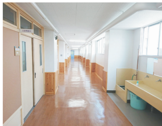
改修されて、明るくピカピカになった廊下。
